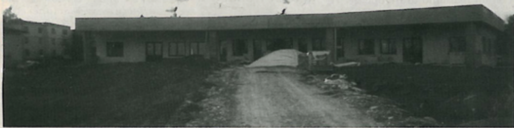
I lavori di costruzione della sede sono quasi al termine.
